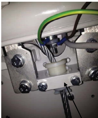
1. Colocar partes plásticas de aislamiento alrededor de la cuerda
